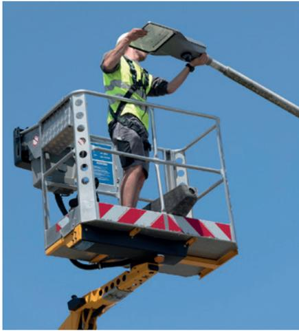
Der Netzelektriker bei der Montage neuer LED-Strassenbeleuchtung.
